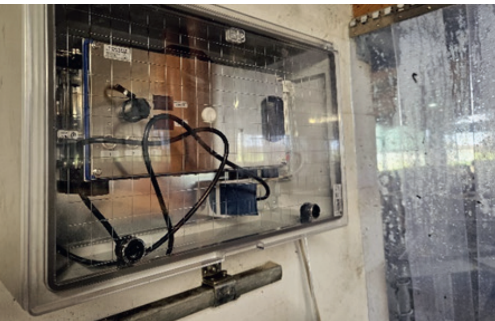
Installation der Gaschromatographen (Sniffer) im OG-Betrieb
